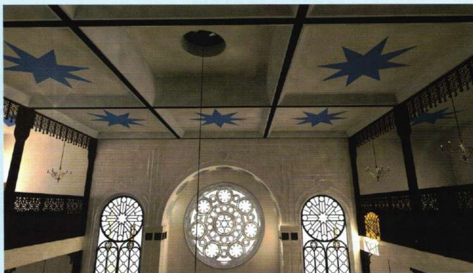
Rekonstruktion Kassettendecke (oberer Deckenabschluss), Visualisierung.
