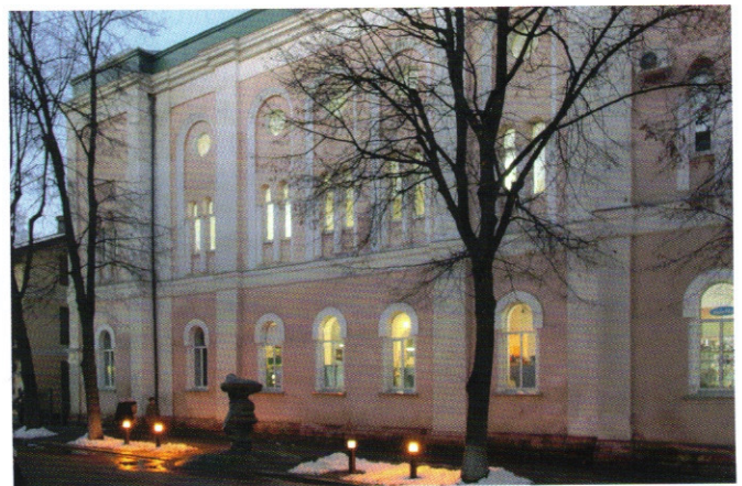
Synagoge, Ansicht der Südfassade, Zustand 2014. Foto: W. Ringitscher, mit freundlicher Genehmigung.
