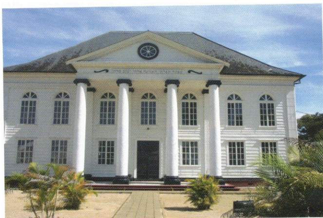
Synagoge Neve Shalom, Außenansicht
