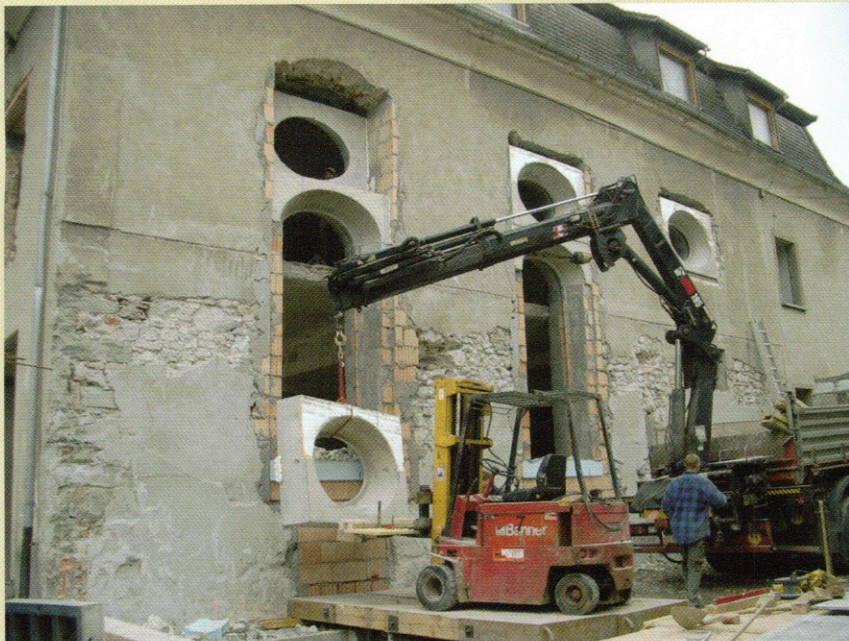
Bauarbeiten zur teilweisen Wiederherstellung des ursprünglichen Aussehens der Synagoge
