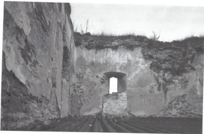
Korneuburg, Blick in die Nordostecke. Zu erkennen sind ein teilweise vermauertes Lanzettfenster und direkt unterhalb der Mauerkrone Reste eines Rundfensters (oben rechts) sowie darunter der Giebelabdruck des Toraschreins (unten rechts), (Foto: S. Paulus 2002)
