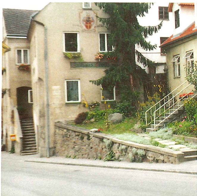
Gasthaus Groß, Wiener Straße 26, an dieser Stelle, befand sich bis 1670 die alte Synagoge (Aufnahme 1994).
