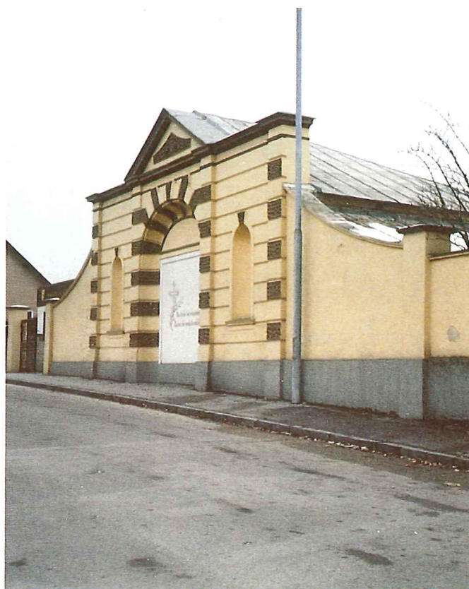
Die baulich stark veränderte ehemalige Leichenhalle des jüdischen Friedhofes (Aufnahme 1992).
