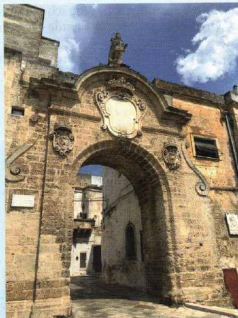
Die Porta degli Ebrei an der Piazza Shabbetay Donnolo in Oria. Aus Oria stammt auch die jüdische Familie Qalonymos , von der sich die Namen Calò und Calimani ableiten. Unweit der Porta degli Ebrei wurden Gräber entdeckt, die auf einen weitläufigen, spätmittelalterlichen jüdischen Friedhof hinweisen.
