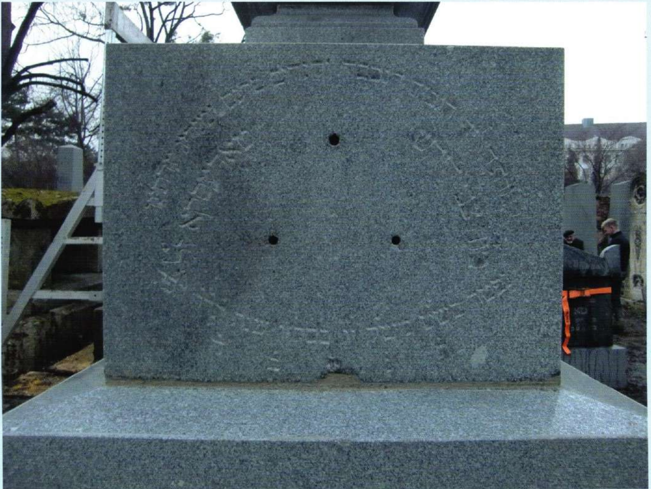
Grabmal Hermann Todesko, ostseitige Inschrift mit fehlender Fassung – vor der Erneuerung, Zustand 2019. Foto: T. Walzer, mit freundlicher Genehmigung.
