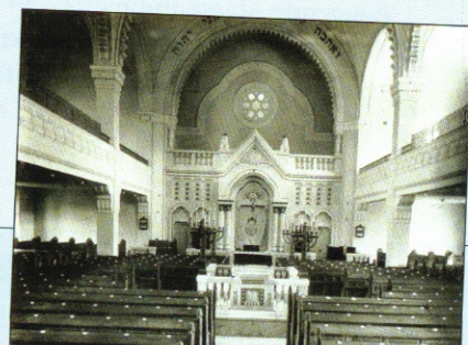
Historische Innenraumaufnahme der Neuen Neologischen Synagoge (Blickrichtung Ost)
