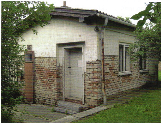
Das ehemalige Friedhofswärterhaus, Zustand 2009.
