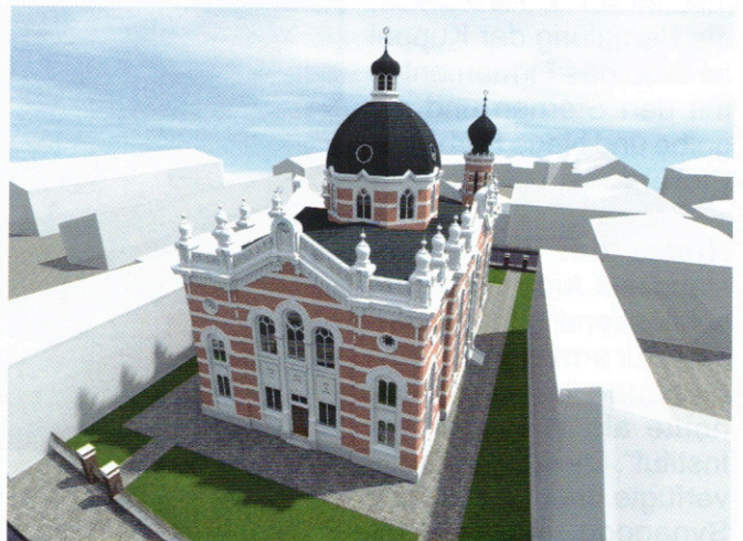
Rückfassade der Synagoge Troppau/ Opava.
