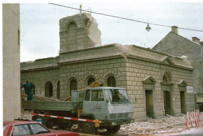
Reste der Baulichkeiten unmittelbar vor dem endgültigen Abriss. Foto: E. Kalt.
