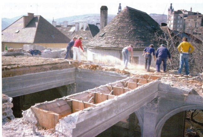
Blick vom abgebrochenen Dach. Foto: E. Kalt 1978.
