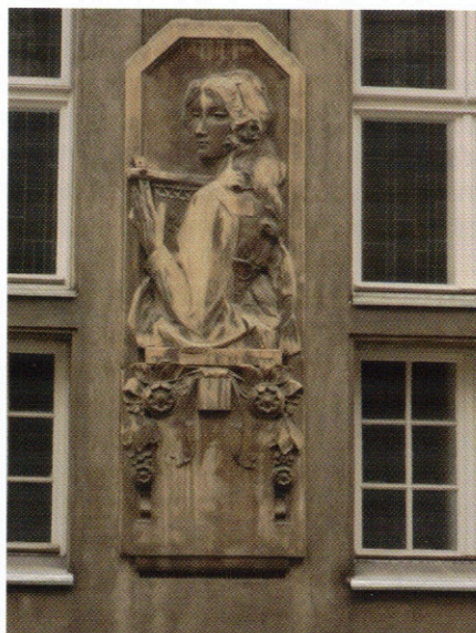
Detail der Fassade des Schulgebäudes. Foto: U. Prokop.
