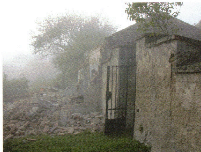
Der Abriß der Zeremonienhalle. Foto zur Verfügung gestellt vom Komitee zur Erhaltung des Jüdischen Friedhofs Klosterneuburg
