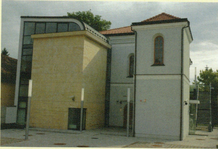
Außenansicht der neu gestalteten Synagoge in Baden/Wien
