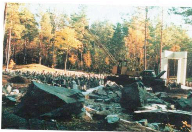
Der Mittelpunkt der Anlage während der Bauphase
