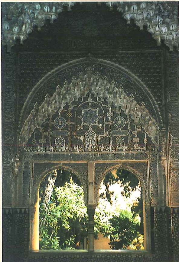
Abb. 2: Dekoratives Fenster der Alhambra in Granada. Man beachte die ausgezackten Spitz- und Rundbogenmotive, wie sie auch in der türkischen Synagoge anzutreffen sind.
