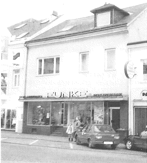
Haus in Amstetten in dem sich einst der Betraum befunden hatte (Ardaggerstraße 8).
